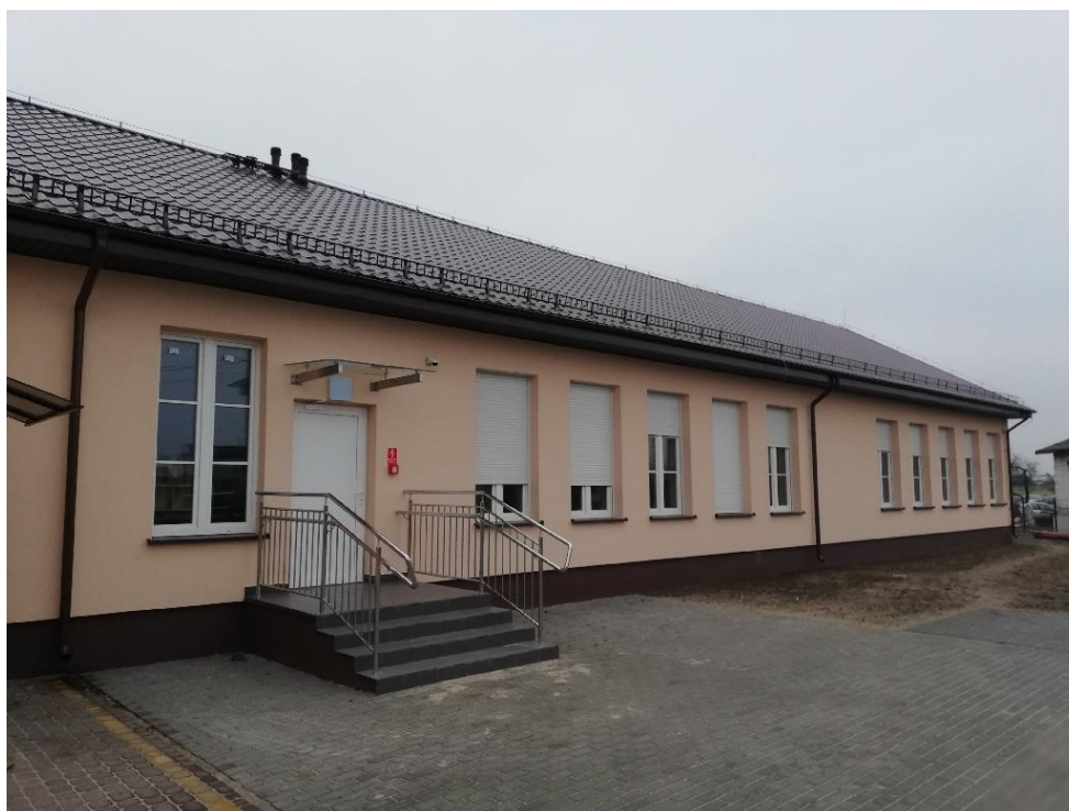
Wejście do budynku.
